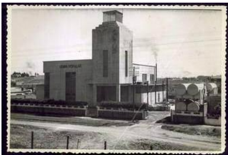
Edificio original de la Usina eléctrica de Tandil. Fotografía de archivo.
