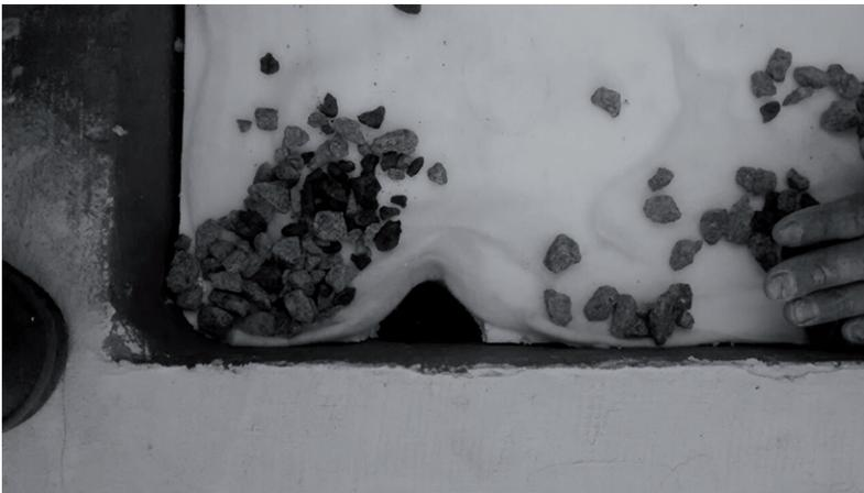
Detalle de protección de resumiadero de losa.
