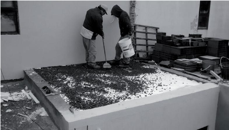
Aislación de losa con tecnología de techo invertido.
