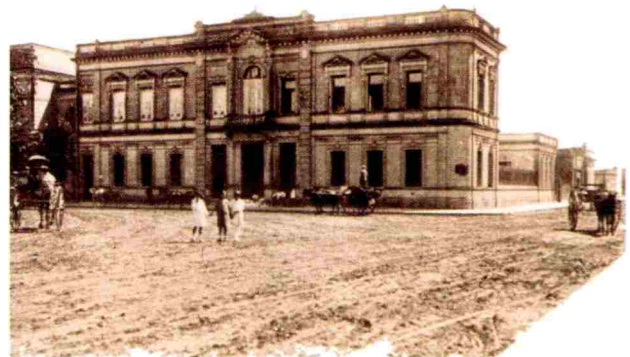
ESCUELA N° 1 "JUAN ESTRUGAMOU". EDIFICIO INAUGURADO EN 1908. FOTO ARCHIVO HISTÓRICO MUNICIPAL
