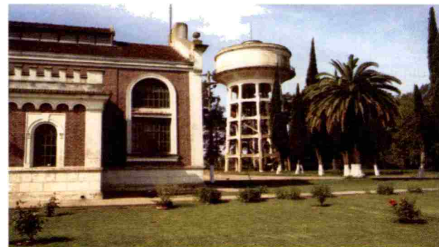
EDIFICIO DE OBRAS SANITARIAS DE CHACABUCO FOTO EDUARDO GUTIÉRREZ
