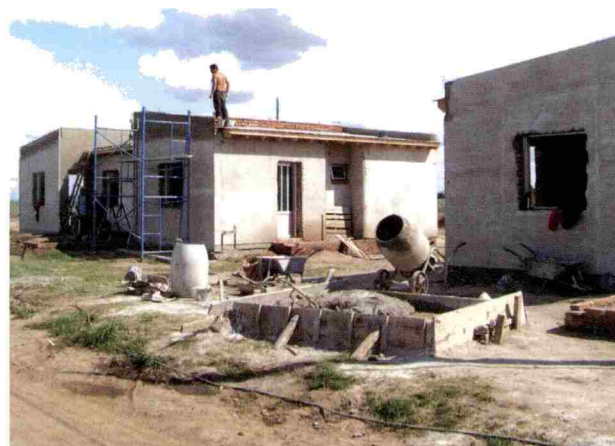
CONSTRUCCIÓN DE VIVIENDAS. FOTO DANIEL ALACIO
