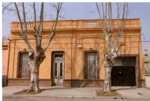
FACHADA EN REMODELACIÓN DEL AULA CHACABUCO FRSN-UTN UBICADA EN CALLE RE- MEDIOS ESCALADA DE SAN MARTÍN 138. FOTO PABLO VILLANUEVA
