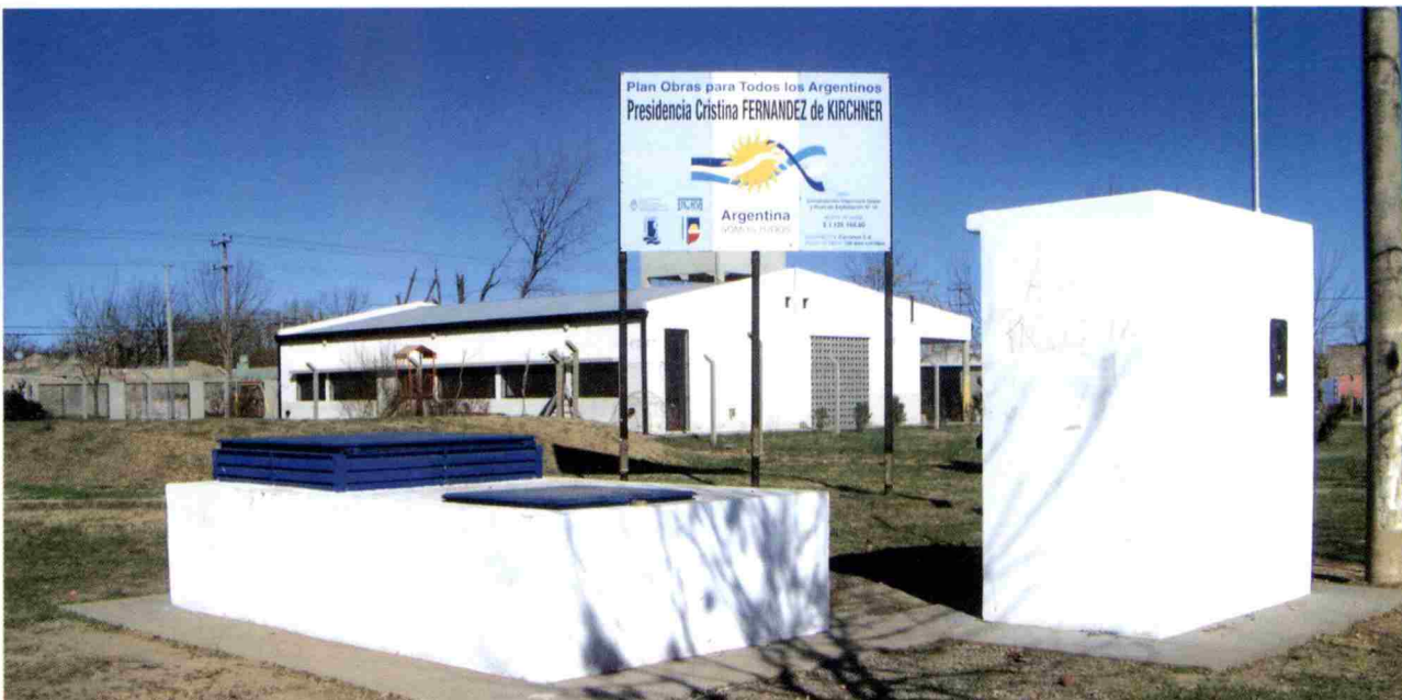
POZO DE AGUA EN EL BARRIO LA ILUSIÓN, AV. JUAN XXIII. FOTO DANIEL ALACIO
