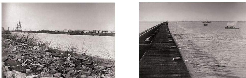
Fig. 27 Escollera de faginaje y Muelle de madera en las entradas de Puerto La Plata, 1888.
