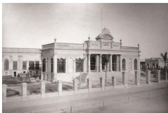
Fig. 15 Edificio del Departamento de Ingenieros de la provincia de Buenos Aires (foto 1883).
