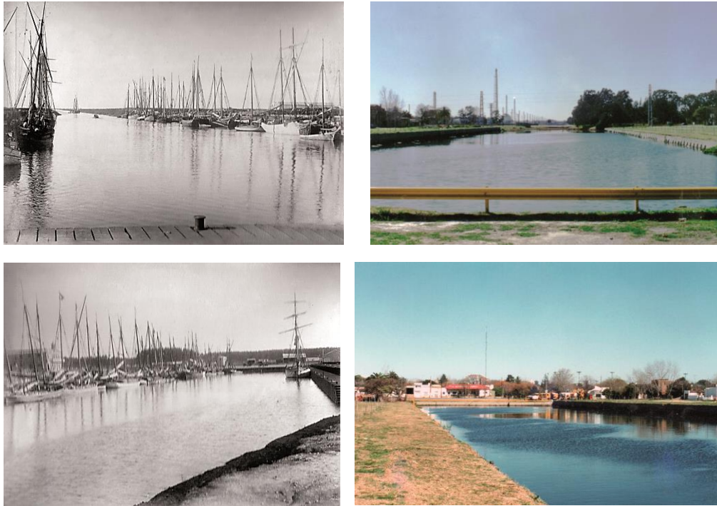
Fig. 22 Dique de Cabotaje N° 1, Plano de Muelles y Malecones (sin fecha).y Canal Oeste, 1888- 2001.
