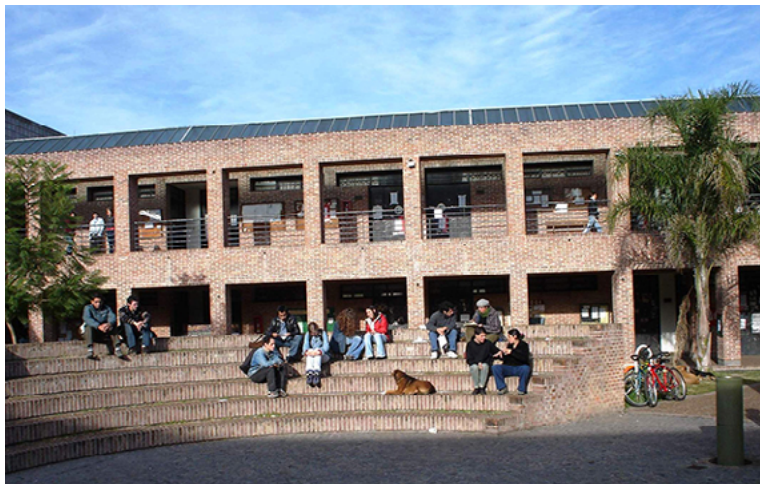
Figura 24. Edificio de Aulas de la Facultad de Ciencias Naturales y Museo, ubicado en calle 60 y 122, inaugurado en el año 1994. Foto: Archivo de la FCNyM.
