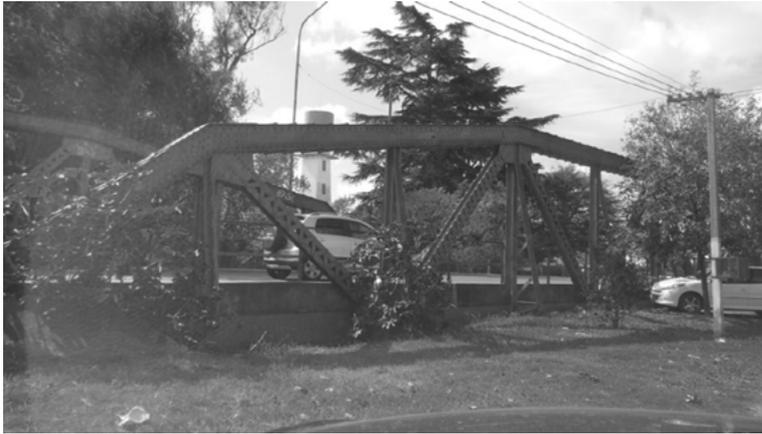
*Figura 13: Obstrucción del escurrimiento natural bajo el puente.*
