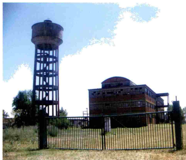
EDIFICIO DONDE FUNCIONÓ EL EX FRIGORÍFICO. FOTO DANIEL ALACIO
