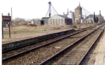
ESTACIÓN DE TREN DE CHACABUCO. FOTO DAM, UNLP
