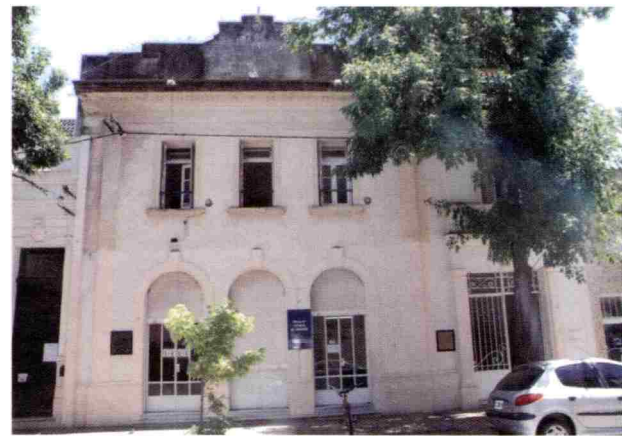
FACHADA DEL EDIFICIO DEL REGISTRO PROVINCIAL DE LAS PERSONAS, OFICINA DE LICENCIA DE CONDUCIR Y CASA DESCENTRALIZADA DE JUSTICIA, DEFENSORÍA DE POBRES FOTO MARCELO FARIAS
