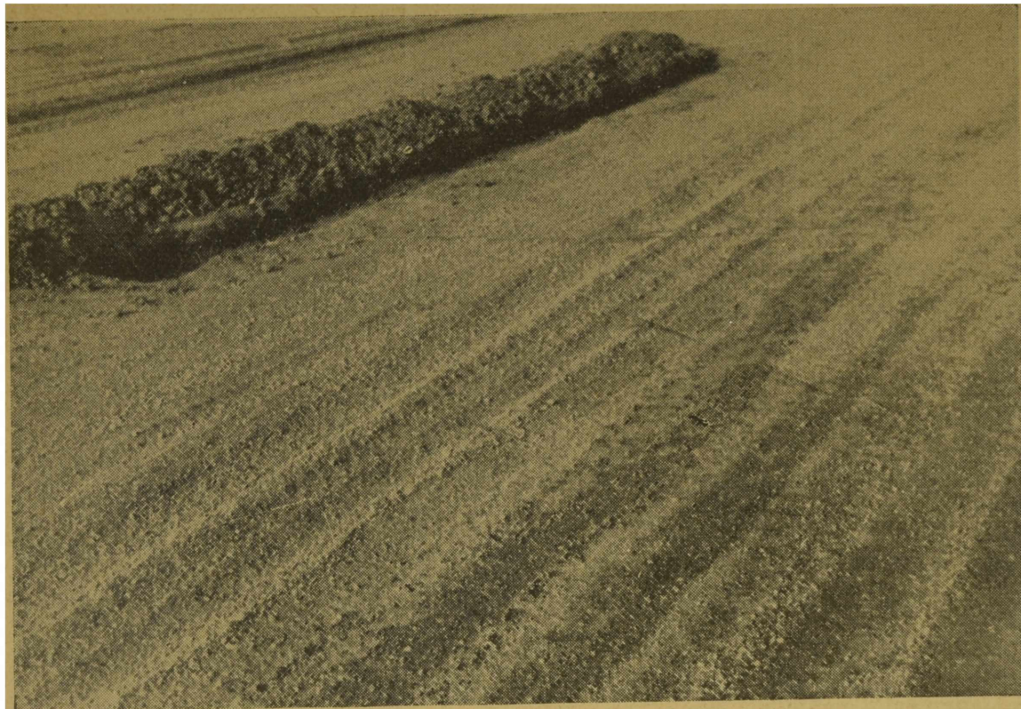
FIG. 3. — Efectos de la distribución desuniforme de humedad en un tipo de mezcla crítica con respecto a la misma.
