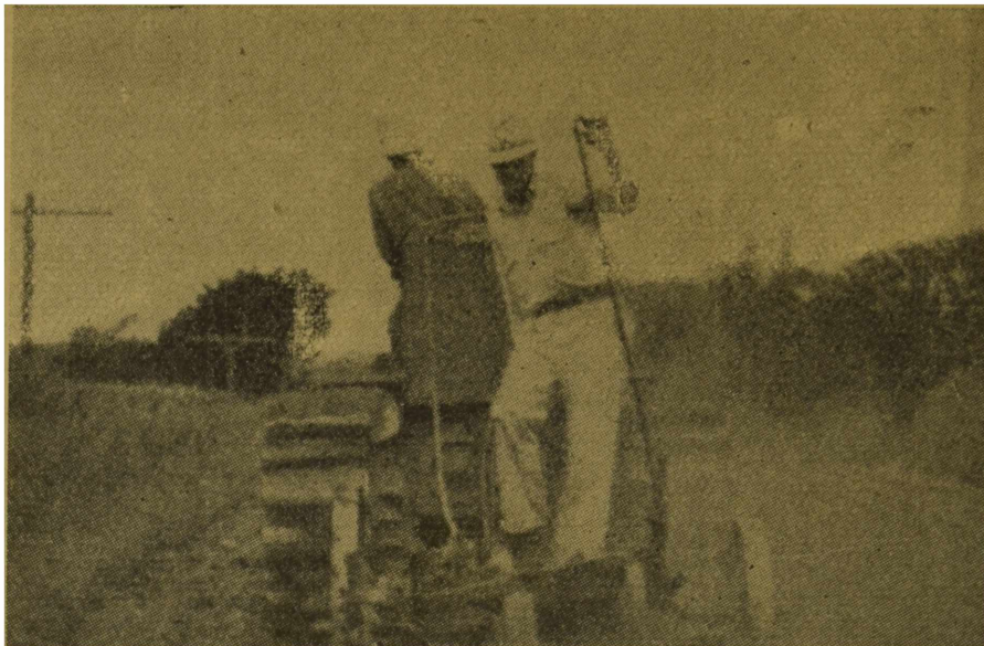
FIG. 71. — Distribuyendo el cemento con motoniveladora.
