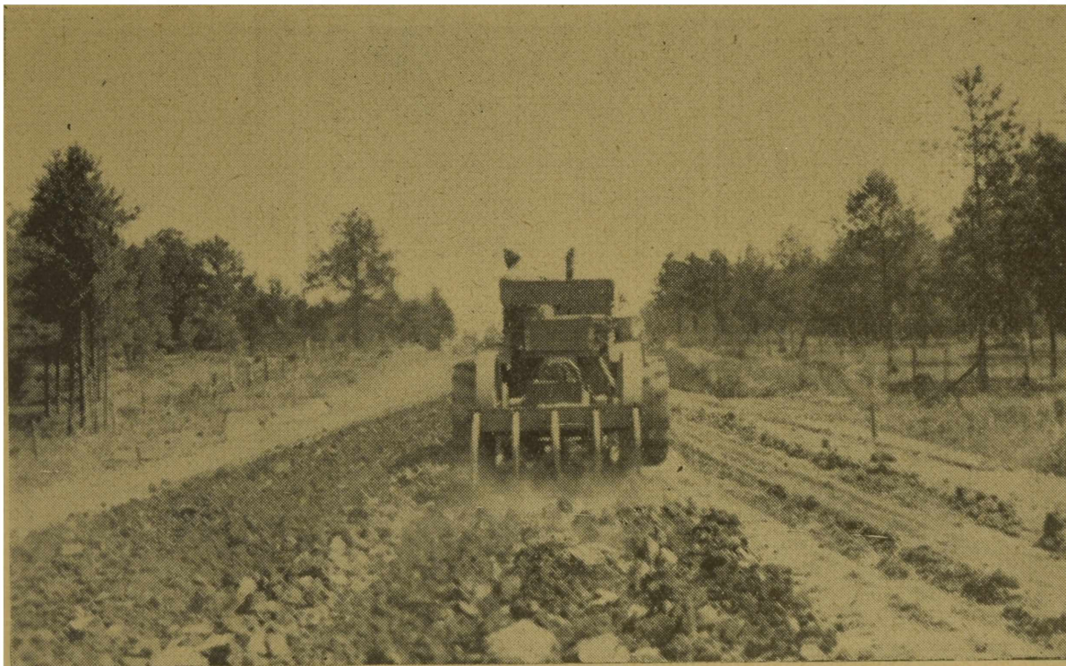
FIG. 65. — Escarificador trabajando en un tramo en construcción en Lancaster (EE. UU. de N. A.).
