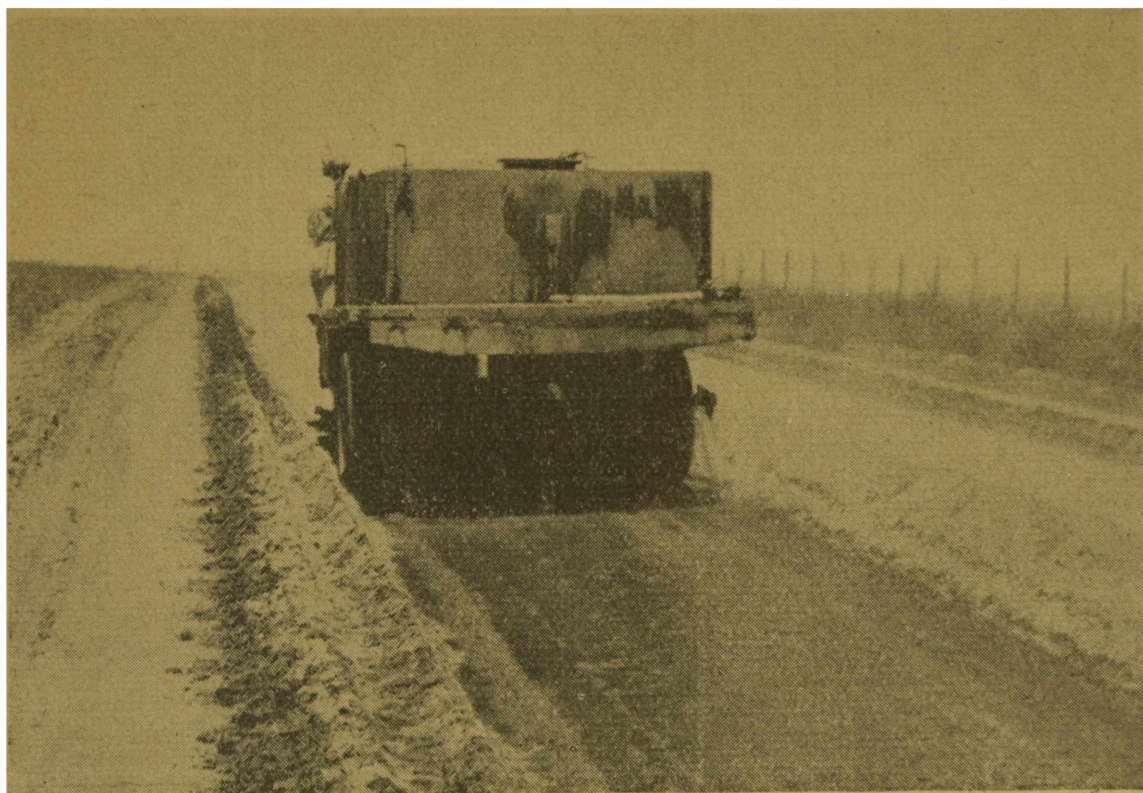
FIG. 8. — La operación de aplicar el agua casi terminada. A fin de uniformar la humedad todo el material es nuevamente juntado en un caballete central.
