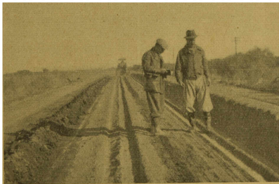
FIG. 91. — Capa regada y relogida.
