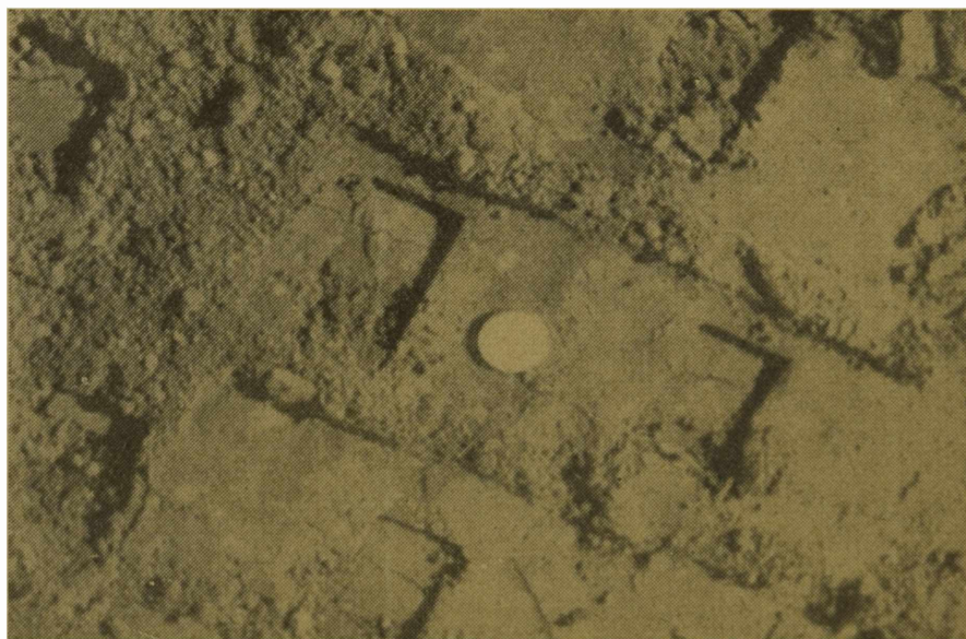
FIG. 105. — Aspecto de la calzada al retirar el rodillo « pata de cabra ».
