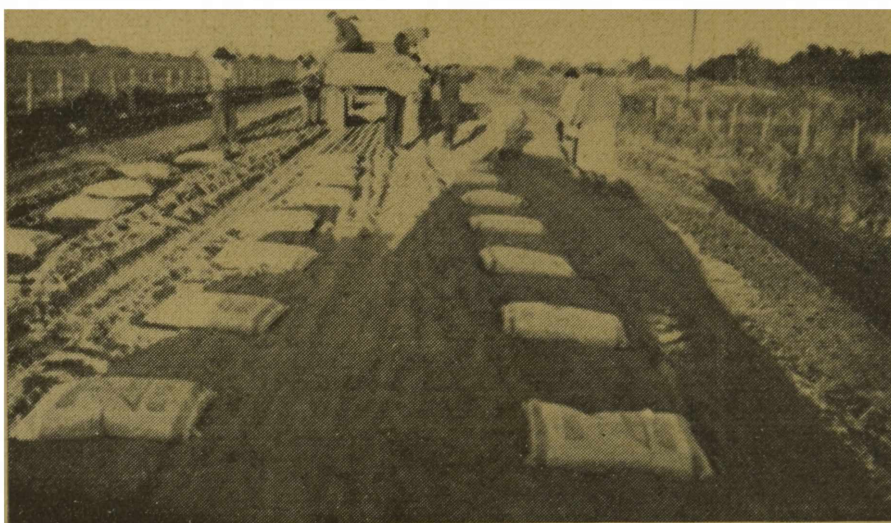
FIG. 68. — Camión descargando directamente las bolsas sobre la calzada
