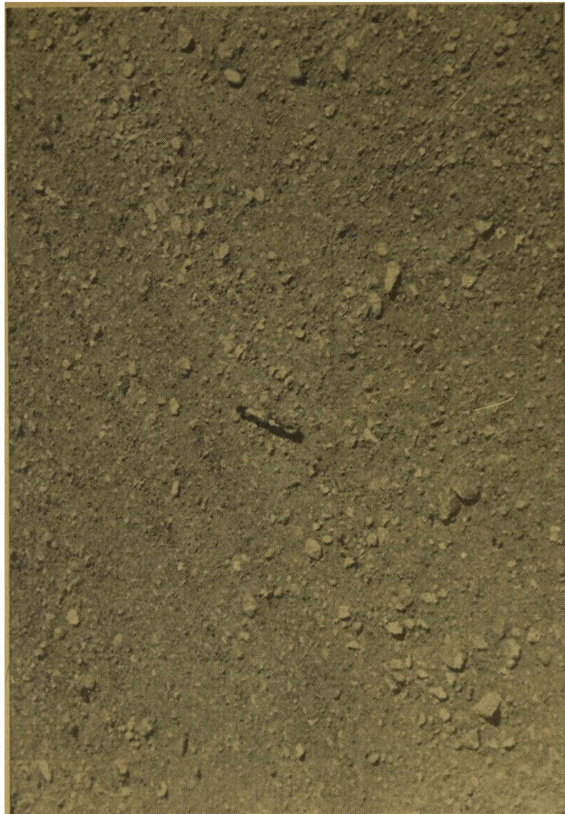
FIG. 2. — Una base tipo « standard » con material segregado por exceso de perfilado.
