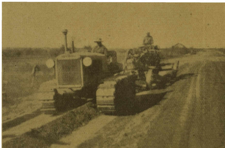
FIG. 101. — Equipo empleado en la formación de banquetas.
