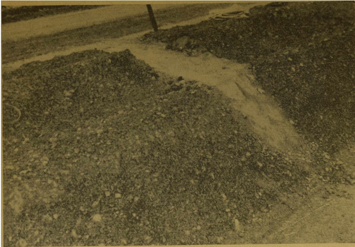
FIG. 5. — Caballete mezclado y uniformado para ser medido. La parte más clara de la figura señala también la cantidad de material que se extrae para el cuarteo.
