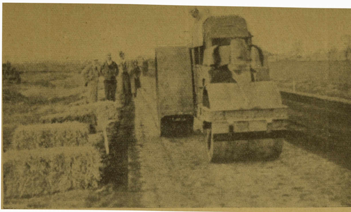
FIG. 118. — Fardos de pasto a utilizar en el curado.
