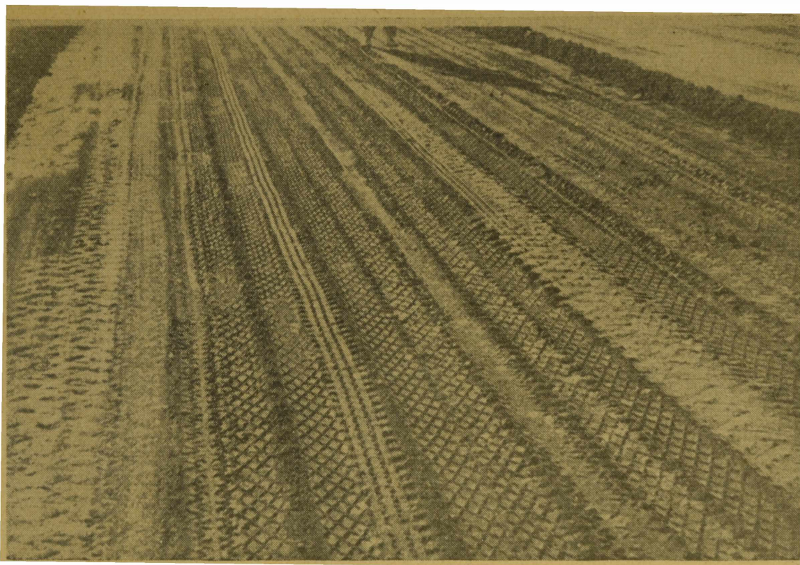
FIG. 13. — Compactación utilizando rodillo neumático solamente. Su efecto sobre una mezcla a contenido óptimo de humedad.
