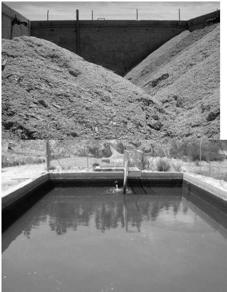
Figura 3.- Tratamiento pasivo en Mina Esperanza: material reactivo y laguna de infiltración en funcionamiento
