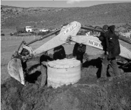
Figura 4. Construcción de un Pozo de Gran Diámetro. Colonia Aborígen Pichiñan. Dpto. Paso de Indios.
