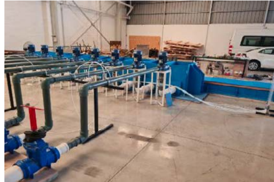
Figura 4: Cámara de aspiración finalizada [2].
