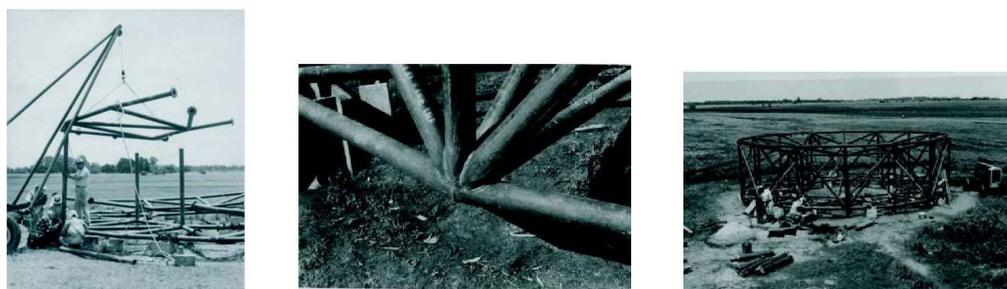
Figura 9 *Izquierda:* Comienzo de la construcción del anillo de acero central. *Centro:* Vista de uno de los nodos. *Derecha:* El anillo central terminado.
