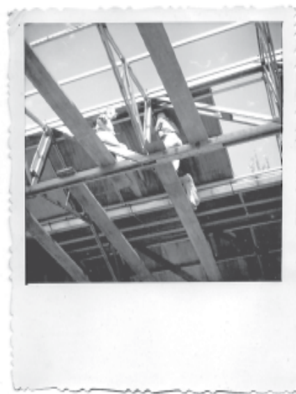
El Arq. Zalba inspeccionando la cubierta
