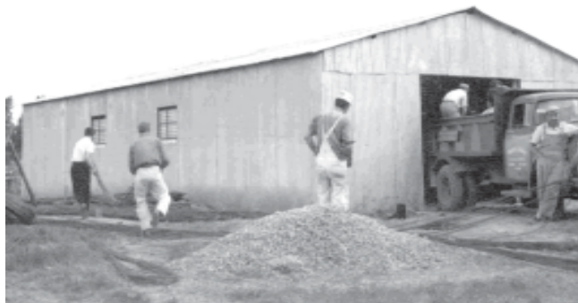
Obrador ATEPAM - Acopio de materiales
