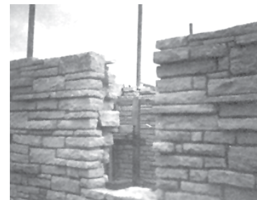
Foto tomada durante la construcción
