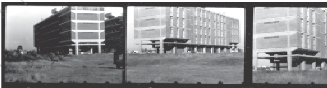
Block prototipo a poco de finalizar la obra
