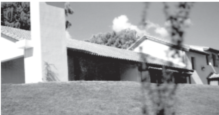
12. Casa Nougués, galería de frente, foto actual. Casa Paz, boceto (abajo)
