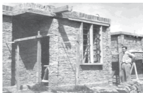
Vivienda de I planta en construcción
