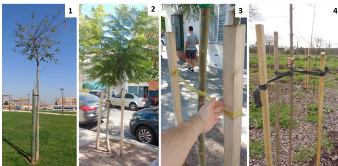
Figura 6.4. Tutorado. (1) Estabilización mediante un solo tutor, colocado enfrentando el viento predominante. (2 y 3) empleando 2 tutores. (4) empleando 3 tutores en zonas ventosas. Fuente: 1. Santiago del Pozo Donoso. 2, 3 y 4. propias.
