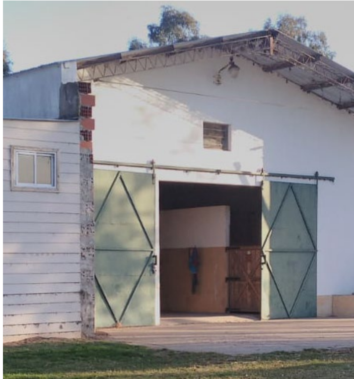
Figura 95 Nave. Vista exterior
