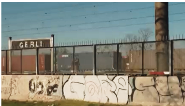
Estación de Gerli.
