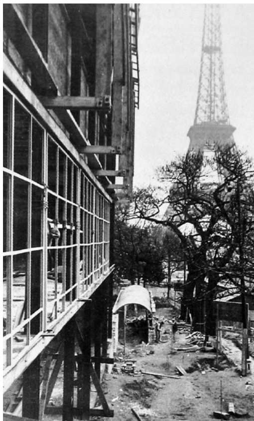
Fig. 5. Pabellón de España en construcción.
