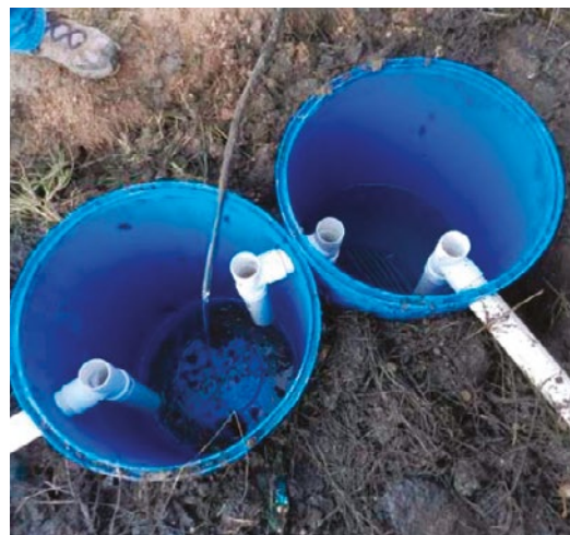
Imágenes 6 y 7. Cámara séptica construida con dos tambores plásticos reciclados.
