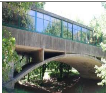
5 – Casa del Puente
