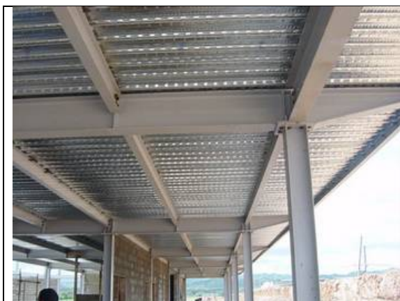
13 – Construcción en acero
