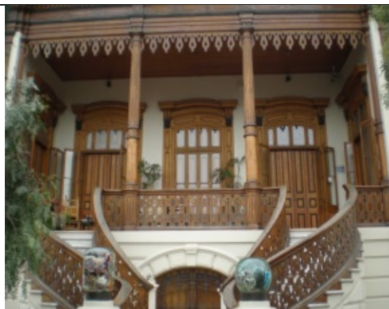
19 – Veranda de acceso casa en Lima, Perú
