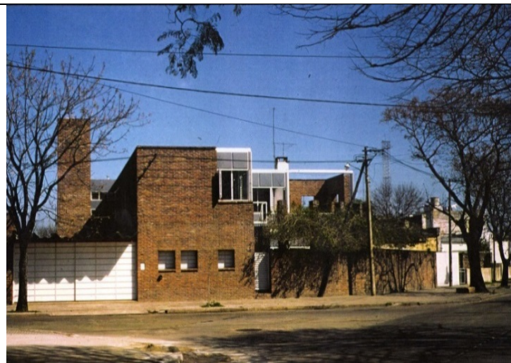
16 - Casa Ostrofsky I: exterior
