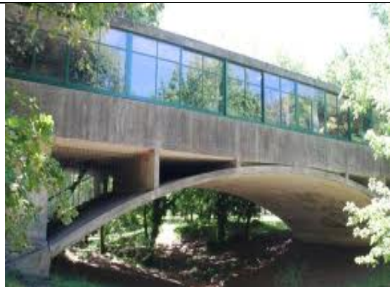
13 – Casa del Puente – A. Williams
