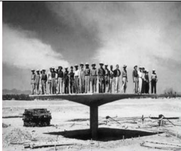
11 - Carga uniformemente repartida
