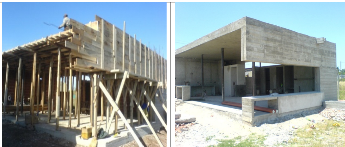
11 – Encofrado y desencofrado – Obra Quintas de Alvear
