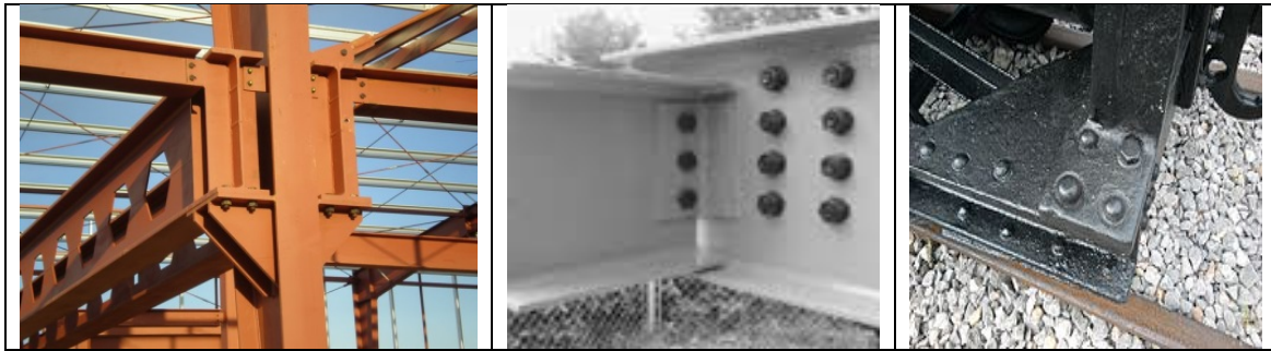
9 - Remaches o roblones, en caliente o en frío.
