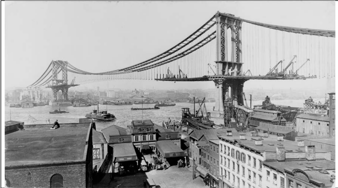
32 - Parábola. Proceso de montaje del Puente de Brooklyn. Fotografía de época.
