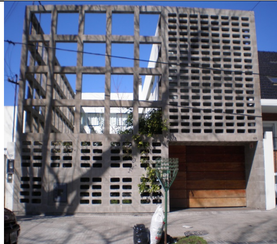
12 – Fachada Casa Ostrofsky II – La Plata
