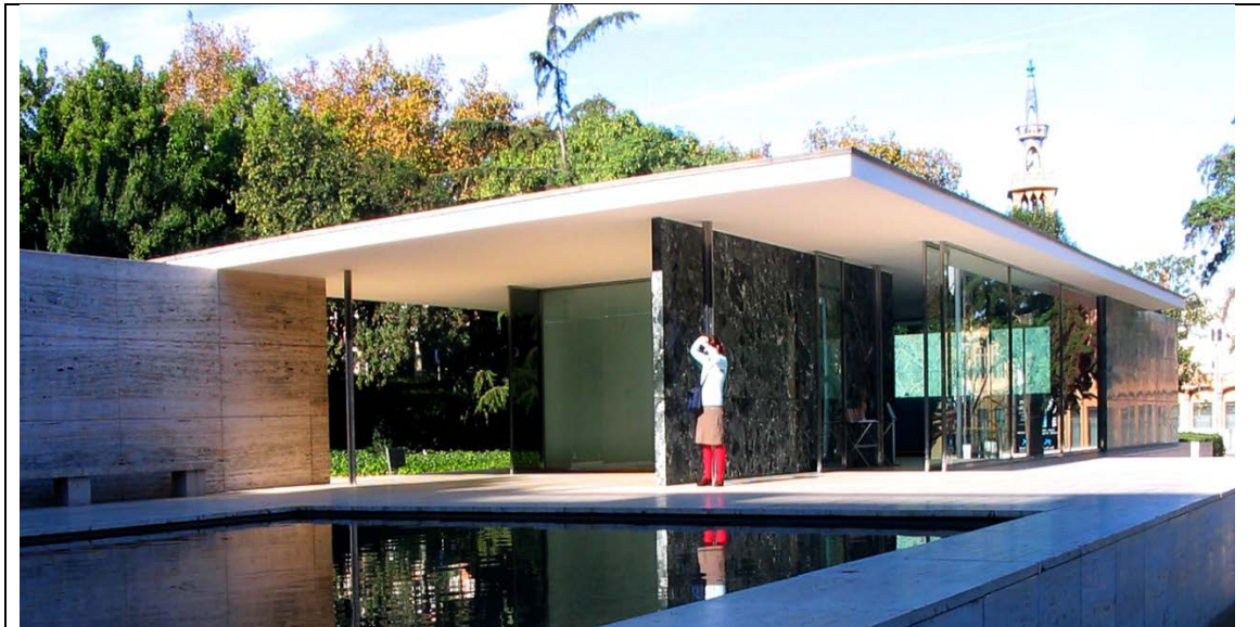
30 - Pabellón de Barcelona – Mies Van de Rohe
