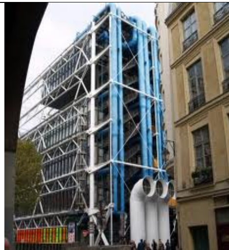
6 - Centro Pompidou: infraestructura
