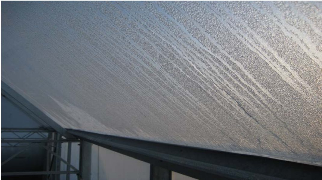
Foto 4: Condensación en plásticos tratados con tensioactivos (Fuente: Juan Ignacio Montero)
