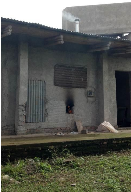
Figura 13. Prueba de funcionamiento de cocina
