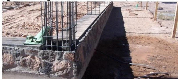
Figura 11 Fotografía sobre-cimiento de piedra
