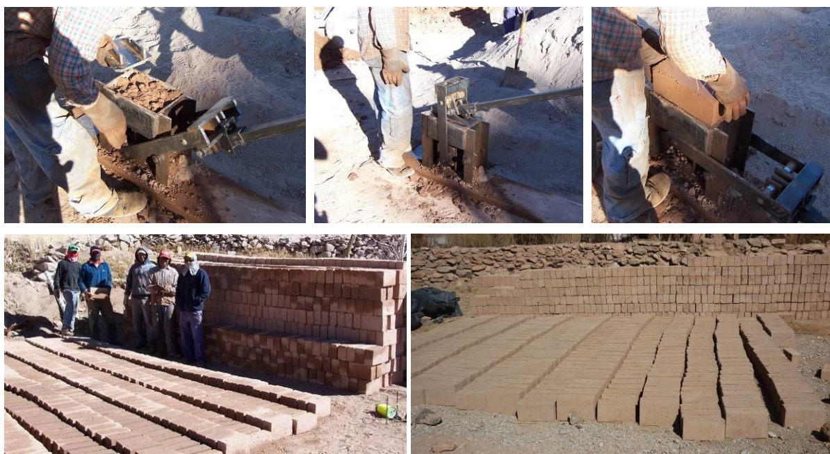
Figuras 3-4- 5- 6 y 7- Fotografías del proceso de construcción de los mampuestos con CINVA-RAM.
