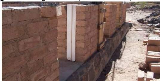
Figura 12 Fotografía mampostería doble c/aislación
