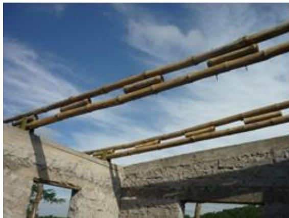
Figura 7. Montaje de viga de sección compuesta
