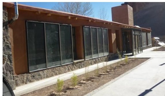
Figura 18 Fotografía muro trombe e invernadero
