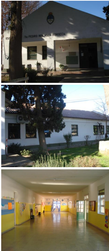
Figura 2. Fotografías exteriores e interior de la circulación principal.
