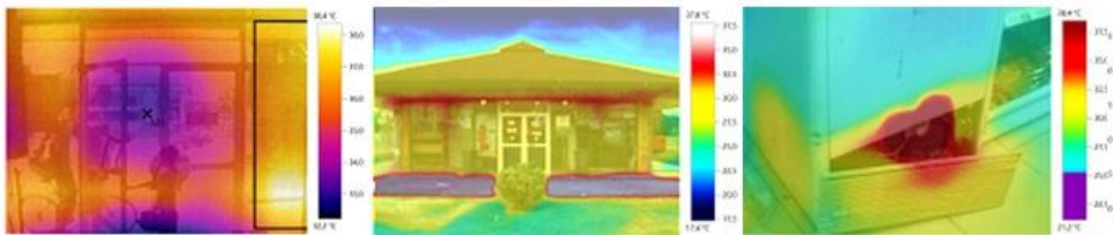
Figura 6. Infiltraciones y focos calientes.
