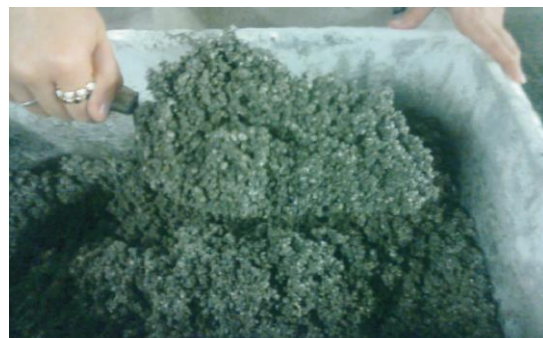
Figura 1. Preparación de Hormigón con EPS
