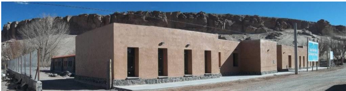
Figura 9 Fotografía fachada principal de la escuela terminada
