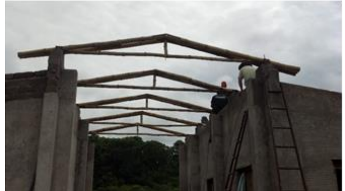
Figura 9. Montaje de reticulado
