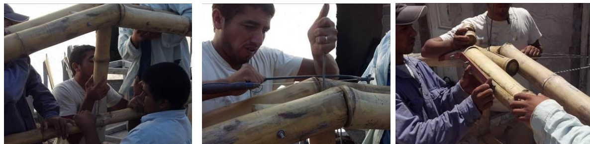
Figura 18. Capacitación en bambú - Cabreada
