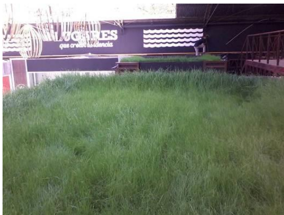
Figura 2. Vista superior de la cubierta verde-primavera
