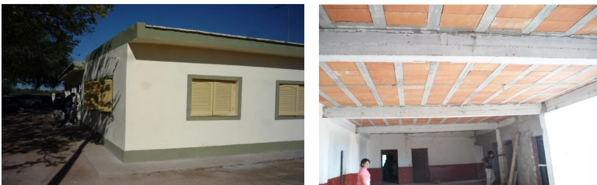
Figura 10: Cerramiento lateral (mampostería) y superior exterior (techo) de la Escuela
