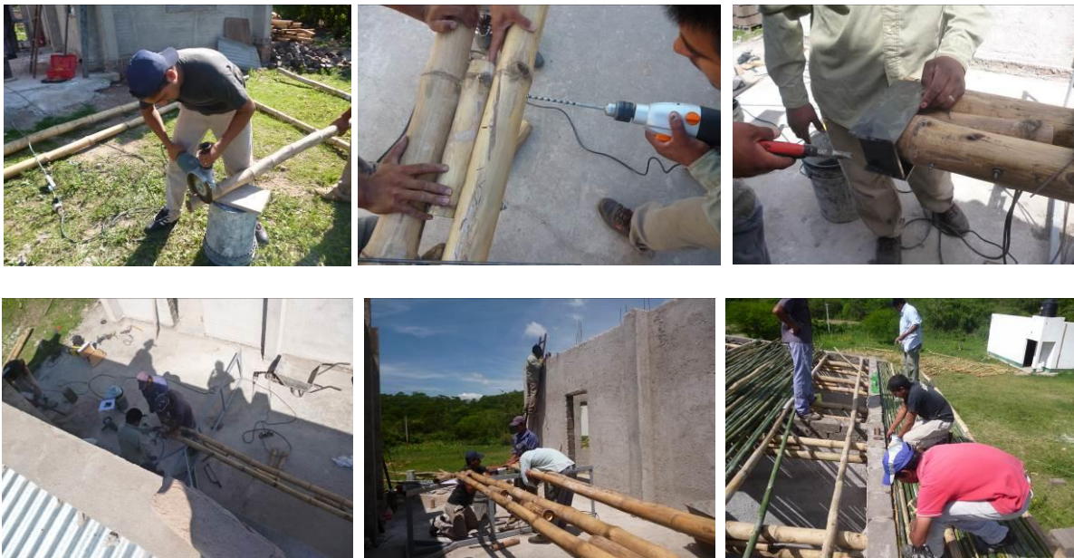
Figura 17. Capacitación en bambú – Viga de sección compuesta
