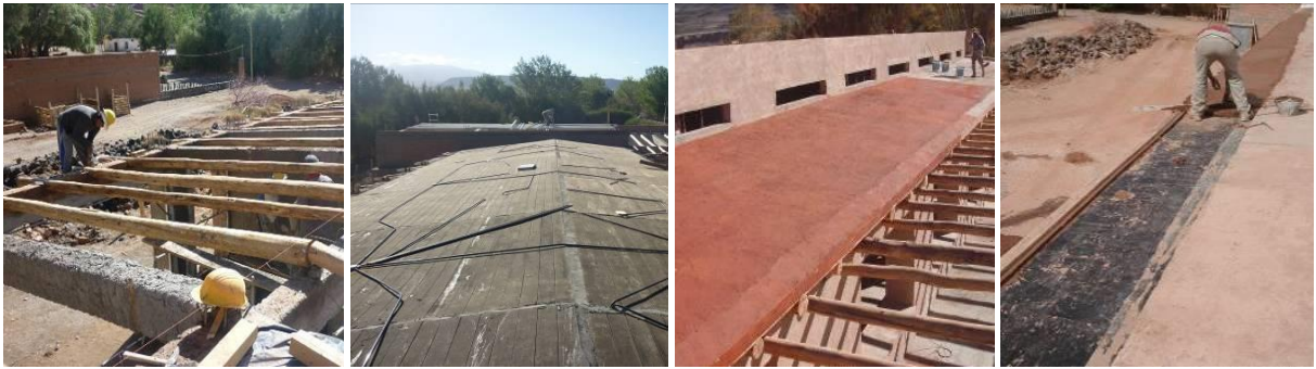
Figura 13 - 14 -15-16 Fotografías de ejecución de la cubierta de torta de barro s/estructura de madera.
