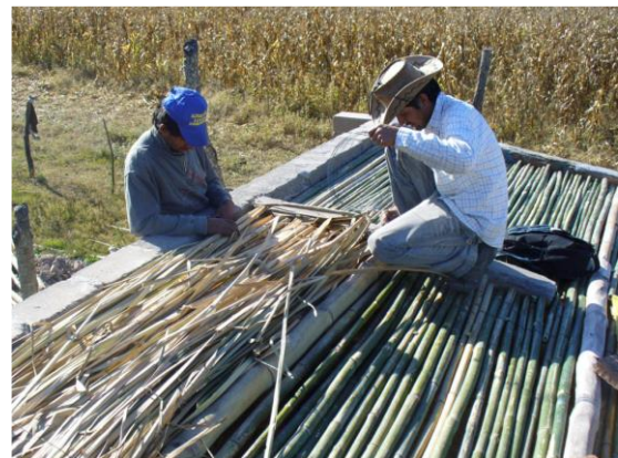
Figura 11. Colocación de totora en cubierta
