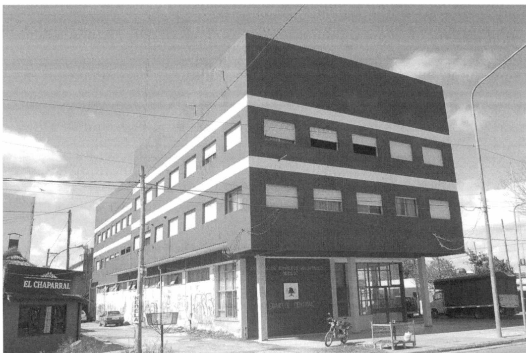
Sede central del cuartel de Bomberos Voluntarios de Berisso, en Trieste (164) entre la avenida 7 (Génova) y 8 (Domingo Leveratto). La Sociedad de bomberos Voluntarios fue creada por un grupo de inmigrantes, el 25 de abril de 1924. Posee dos destacamentos ubicados en los barrios de El Carmen y en el Barrio Banco Provincia.
