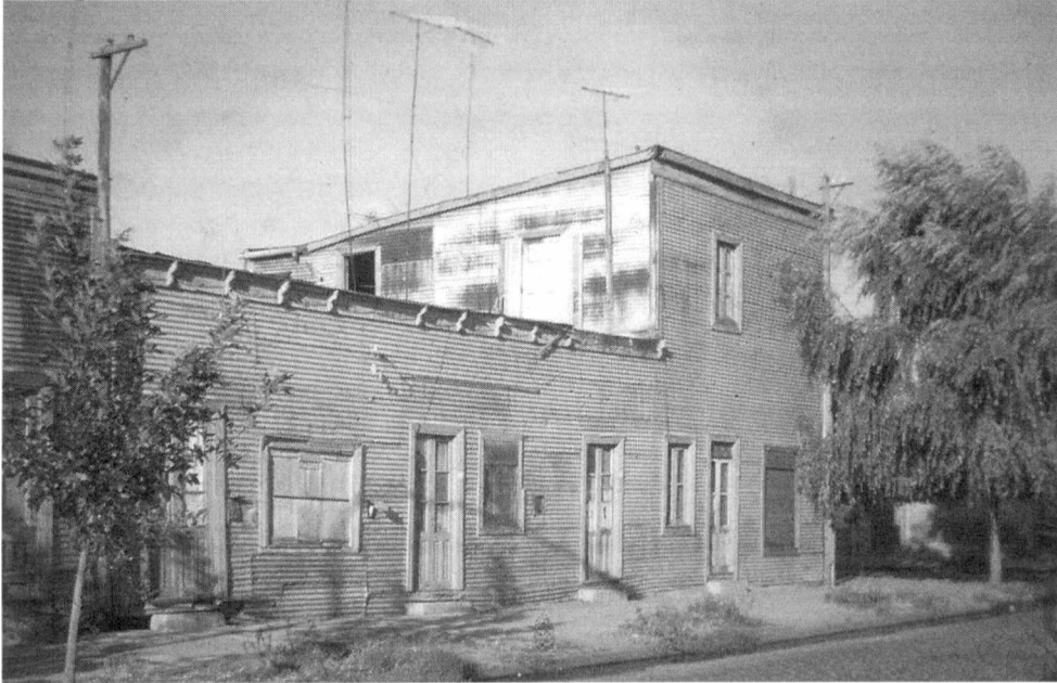
Característica vivienda de cinc acanalado y madera de pinotea, con planta alta, en el barrio de "Las catorce", sobre la calle 168 (Valparaíso), hoy desaparecida. Vivieron allí diversos inmigrantes que aprovecharon su cercanía a los frigoríficos, pudiendo trasladarse a pie a los mismos. Fotografía: Juan F. Klimaitis. 14 feb 1980
