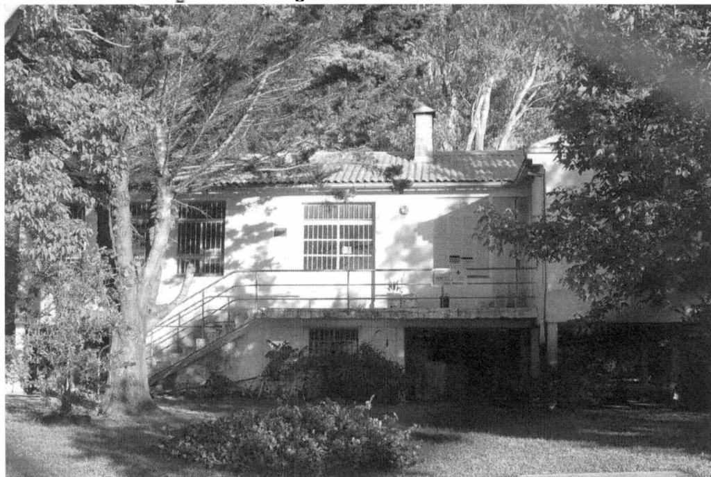
En el interior de la frondosa arboleda característica de la Isla Paulino, se levanta un blanco edificio que tuvo varios destinos, brindando asistencia a los habitantes locales. En primer lugar funcionó como Escuela primaria, posteriormente como Sala de Primeros Auxilios y hoy en día es el Centro de Educación Física N° 67. Juan F. Klimaitis. 27 oct 2007
