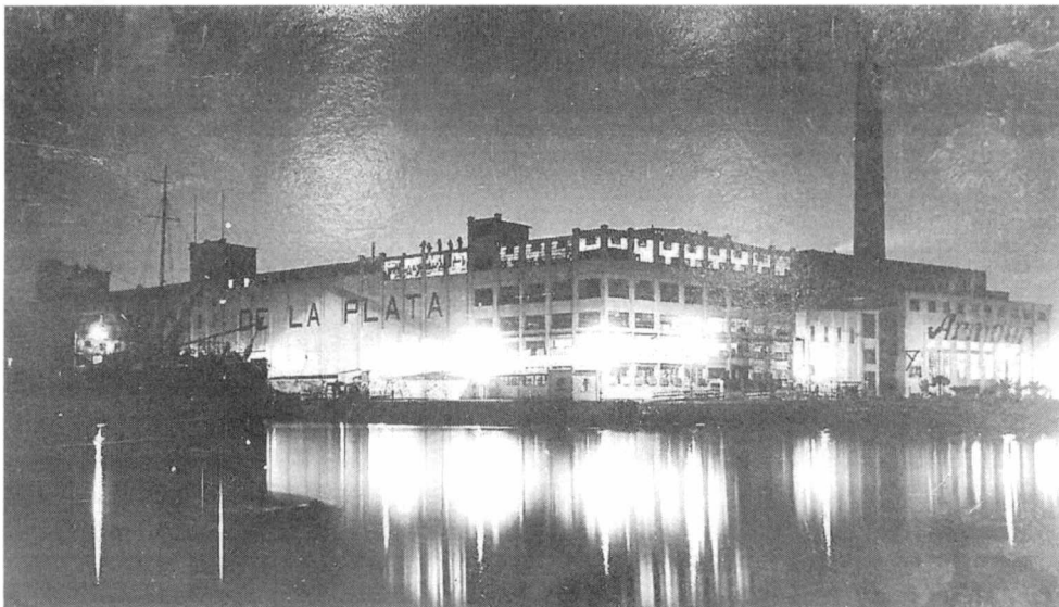
Frigorífico Armour visto de noche, en pleno funcionamiento. Fue demolido en 1983.
