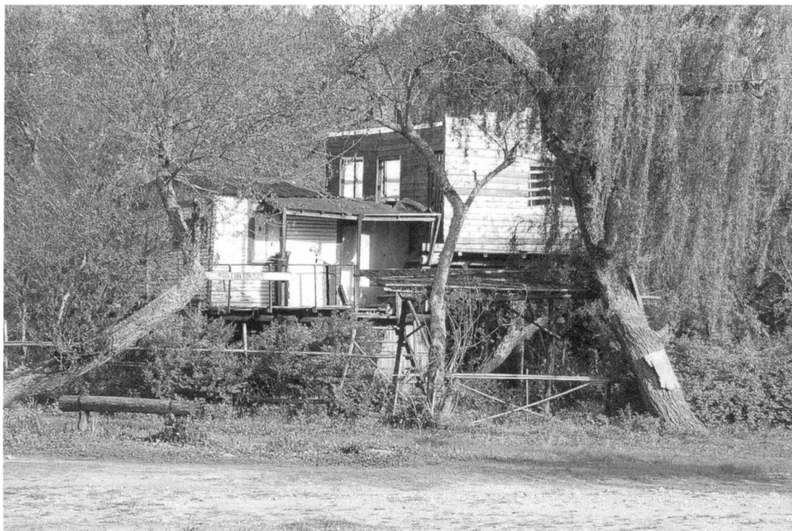
Característica vivienda de la costa berissense, en medio del bosque de saucedales, elevada con una suerte de “zancos” (palafito) para evitar el ingreso de las aguas del Río de La Plata, en sus periódicas crecidas o más graves sudestadas. Sus habitantes se constituyen en los auténticos pobladores ribereños, pescadores y caminadores en madrugadas de húmedas arenas. Palo Blanco. Fotografía: Juan F. Klimaitis. 24 nov 2007
