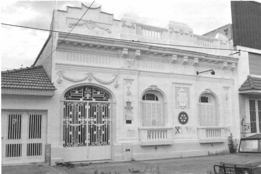
Magnífica fachada, plena de matices arquitectónicos, perteneciente a la sede del Rotary International en 165 (Ostende) entre 8 (Domingo Leveratto) y 9 (Nápoles). Durante las décadas del '50 y del '60, en particular, fue vivienda y consultorio médico del Dr. Carlos Bartolucci, uno de los profesionales de la salud más destacados del Berisso en su dorada edad laboral. También funciona aquí la Asociación Croata Raíces Istrianas de La Plata, Berisso y Ensenada. Fotografía: Juan F. Klimaitis. 28 ene 2016
