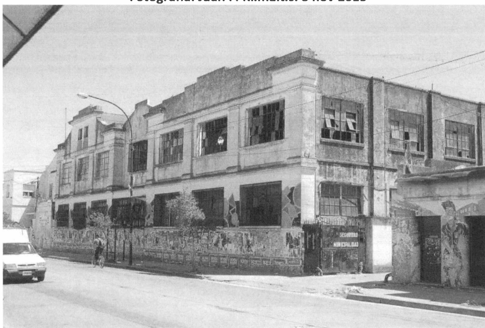
Frente de la antigua “Fábrica de Tejidos The Patent Knitting Co. Ltda”, más conocida como “La Hilandería”, sobre la avenida Montevideo entre 8 (Domingo Leveratto) y 9 (Nápoles). Fue una empresa de capitales ingleses fundada en 1925 y dedicada a la industria textil, en cuya época dorada llegó a tener hasta 450 trabajadores, confeccionando fundamentalmente bolsas para embalado de carne en los frigoríficos. En 1968 cerró sus puertas, para seguir trabajando luego como una Cooperativa. Fotografía: Juan F. Klimaitis. 2 dic 2015
