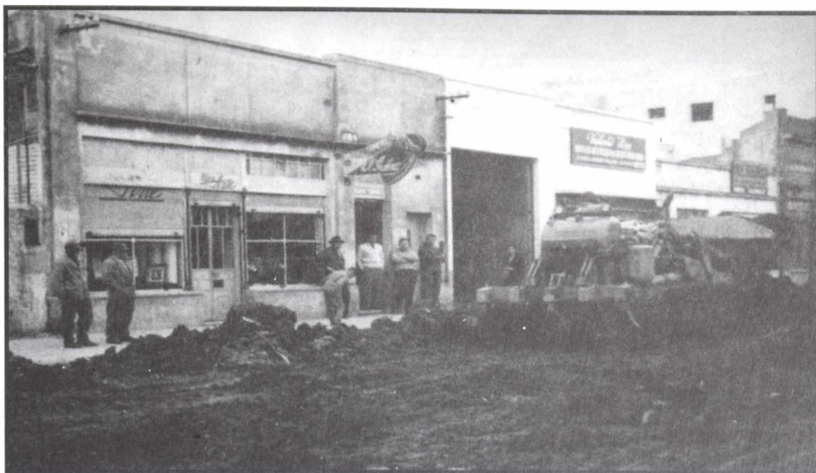
En 1966 se repavimenta la calle Montevideo. (Fotos de Serafín Kowalewski)
