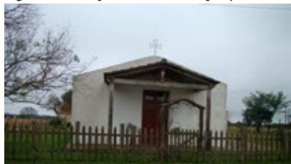
Figura N°12. Capilla de uno de los parajes.
