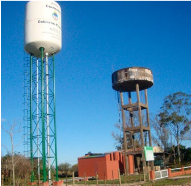
Figura N° 2. Tanque de agua antiguo y tanque de agua nuevo del pueblo.
