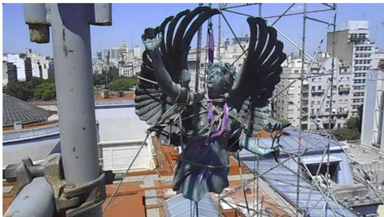
*Figura 39. Desmontaje de la mitad superior, Victoria Alada Doble Izquierda sector Senado.*
