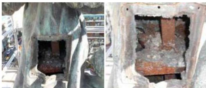
*Figura 60. Estado al abrir la tapa de inspección.*
