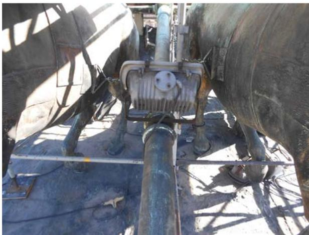
*Figura 22. Luminaria agregada sobre el eje del carro de la Cuadriga.*
