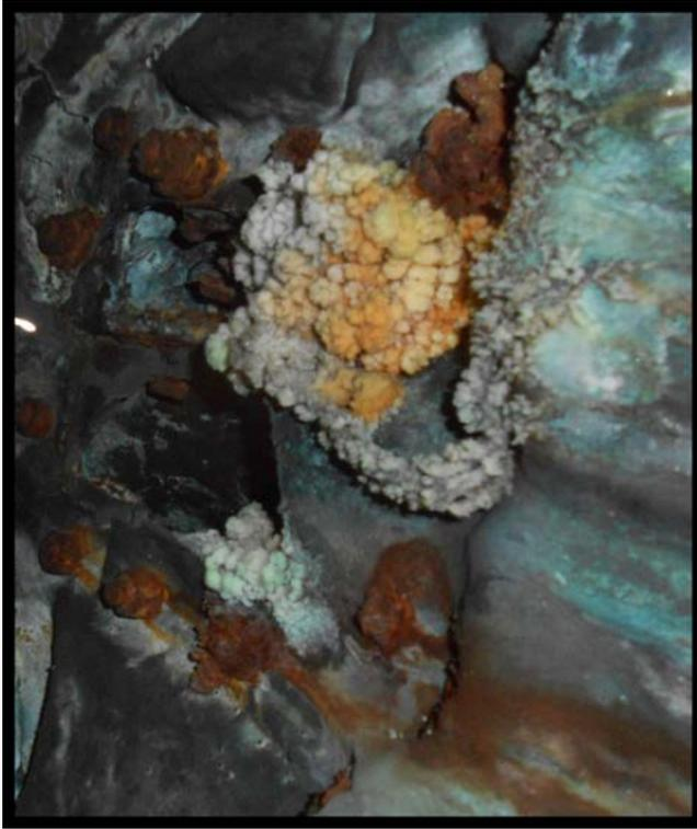
*Figura 37. Fotografía endoscópica. Tuercas y bulones de ensamble entre alas y cuerpo en Victoria Doble Izquierda Sector Senado en grave estado de mineralización.*
