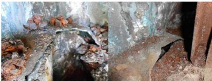
*Figura 62. El antes y después de la limpieza superficial de la oxidación (los bulones de sujeción estaban totalmente corroídos)*
