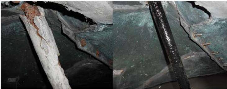
*Figura 72. Columna anterior soporte rueda de carro izquierda antes y después de la intervención.*
