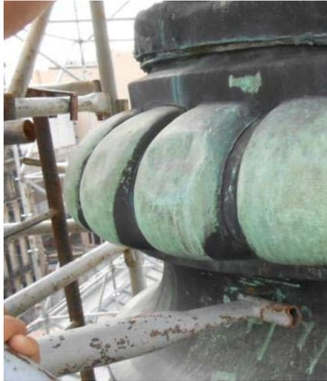
*Figura 55. Abollón en moldura.*
