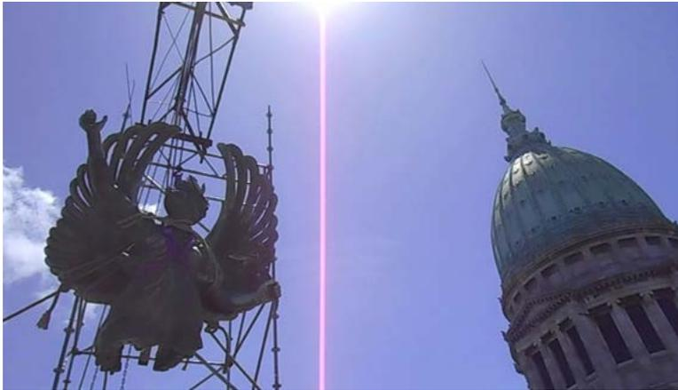
*Figura 64. Desmontaje parte superior de la Victoria Alada Simple sector Senado (Operación realizada junto a la Empresa Techos Dörfler)*
