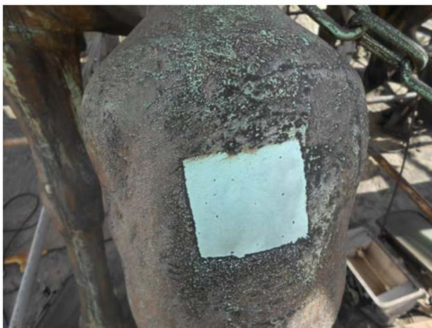
*Figura 23. Marca por corrosión diferencial en pata de caballo de la Cuadriga.*
