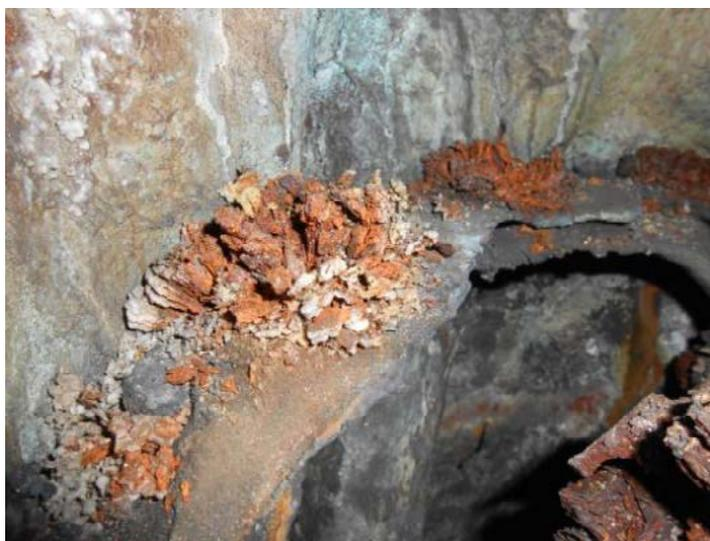
*Figura 63. Estado al abrir la tapa de inspección. Victoria Alada doble izquierda sector diputados.*
